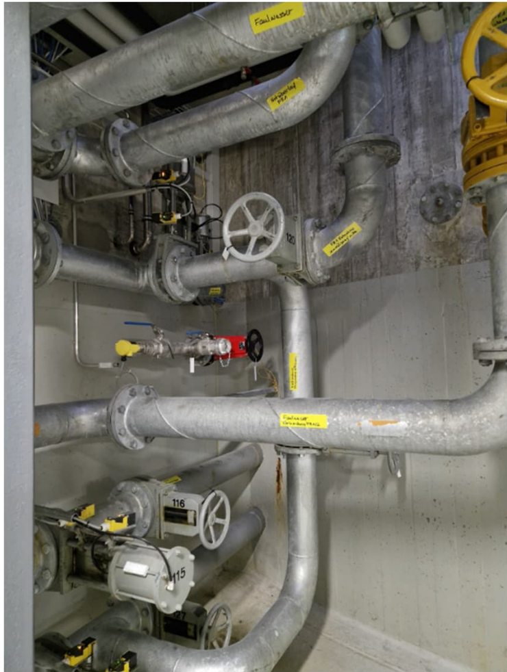
Faulräume – Ersatz Rohrleitungen
